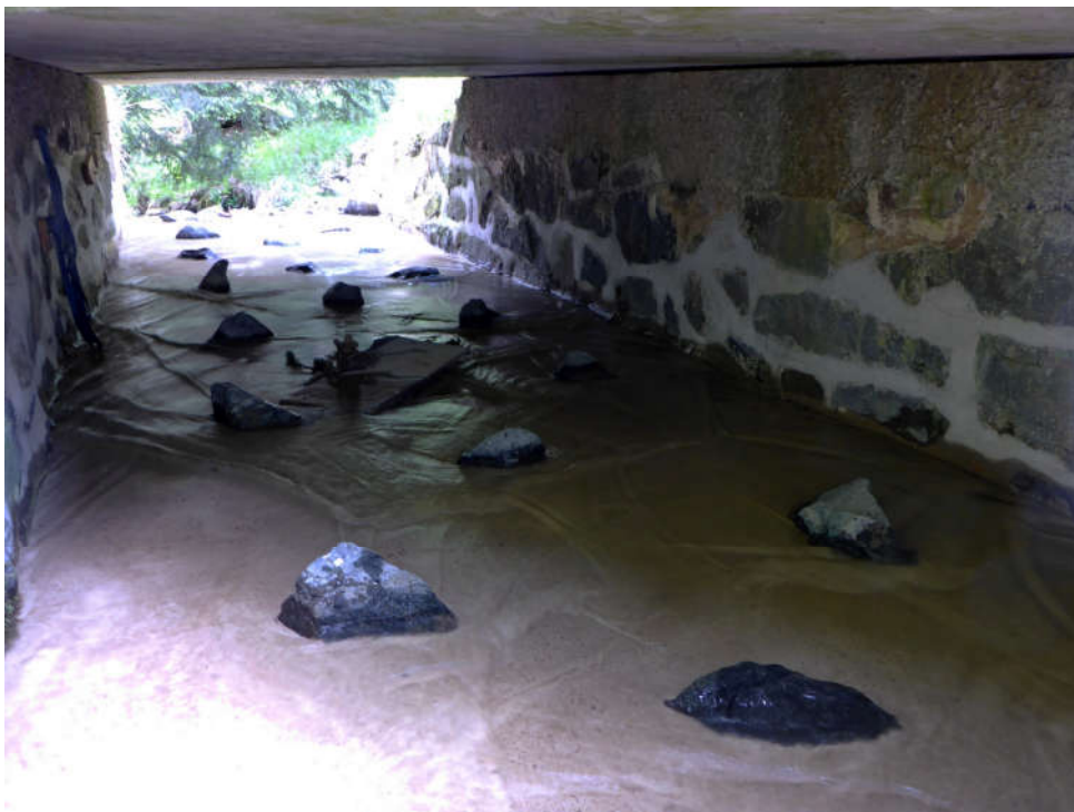
Abbildung 1: Massive Sohlbefestigung unter der neuen Brücke über die Große Hune
