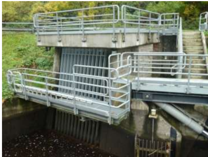
Abbildung 2: Wehranlage am Stolleneingang Radau
