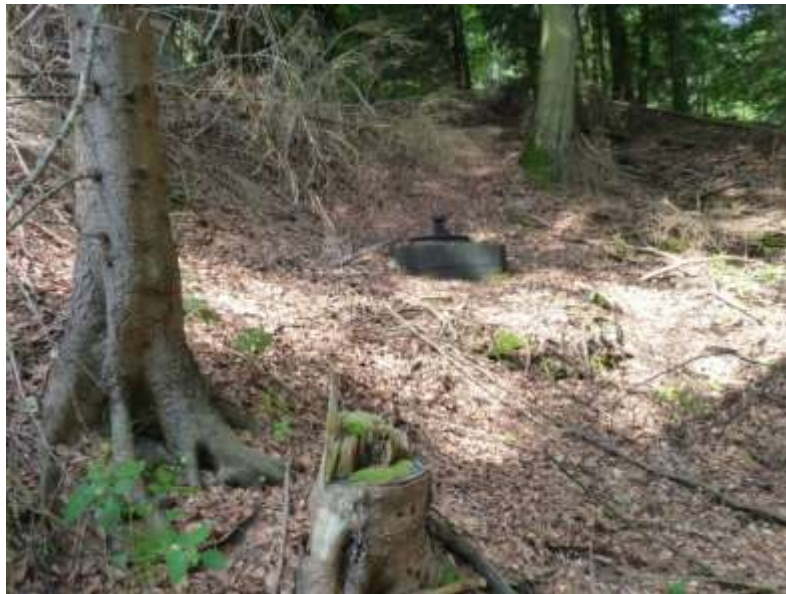
Abbildung 1: Quellfassung im Bereich des Schniggenlochs
