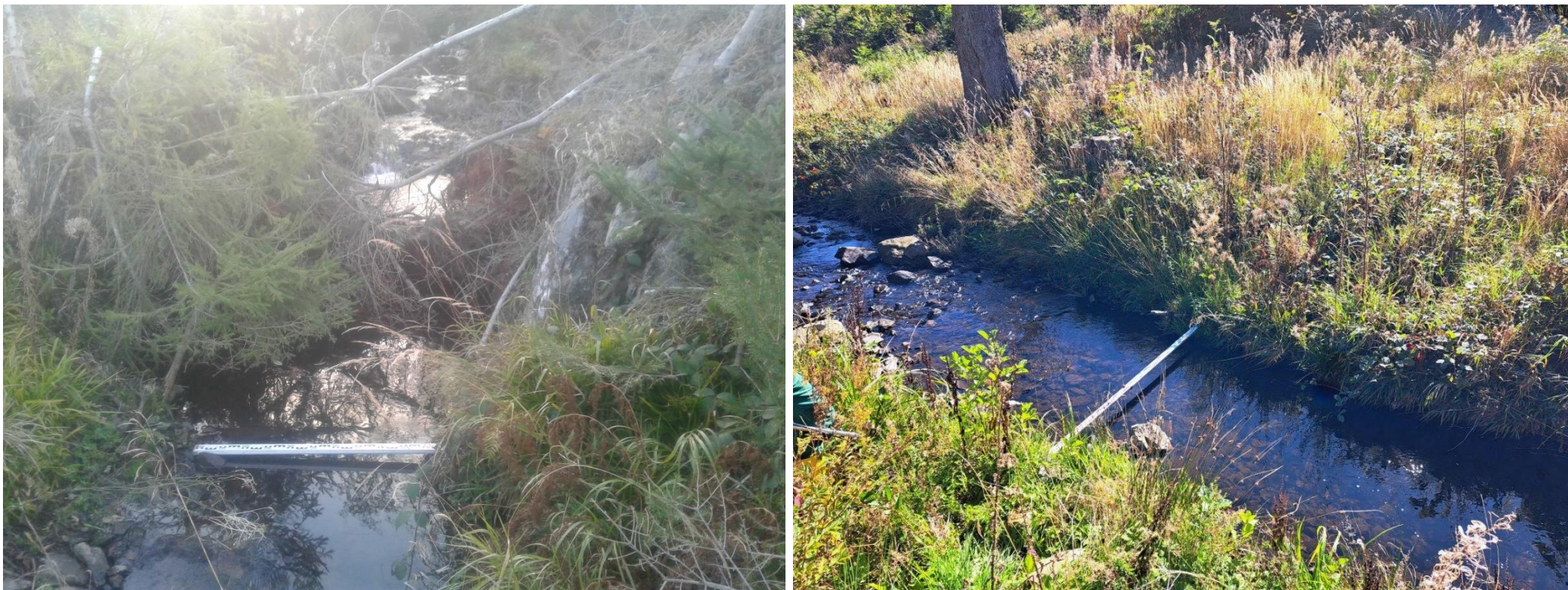
Bild 3: Tiefenbach L: November 22 R: September 23
