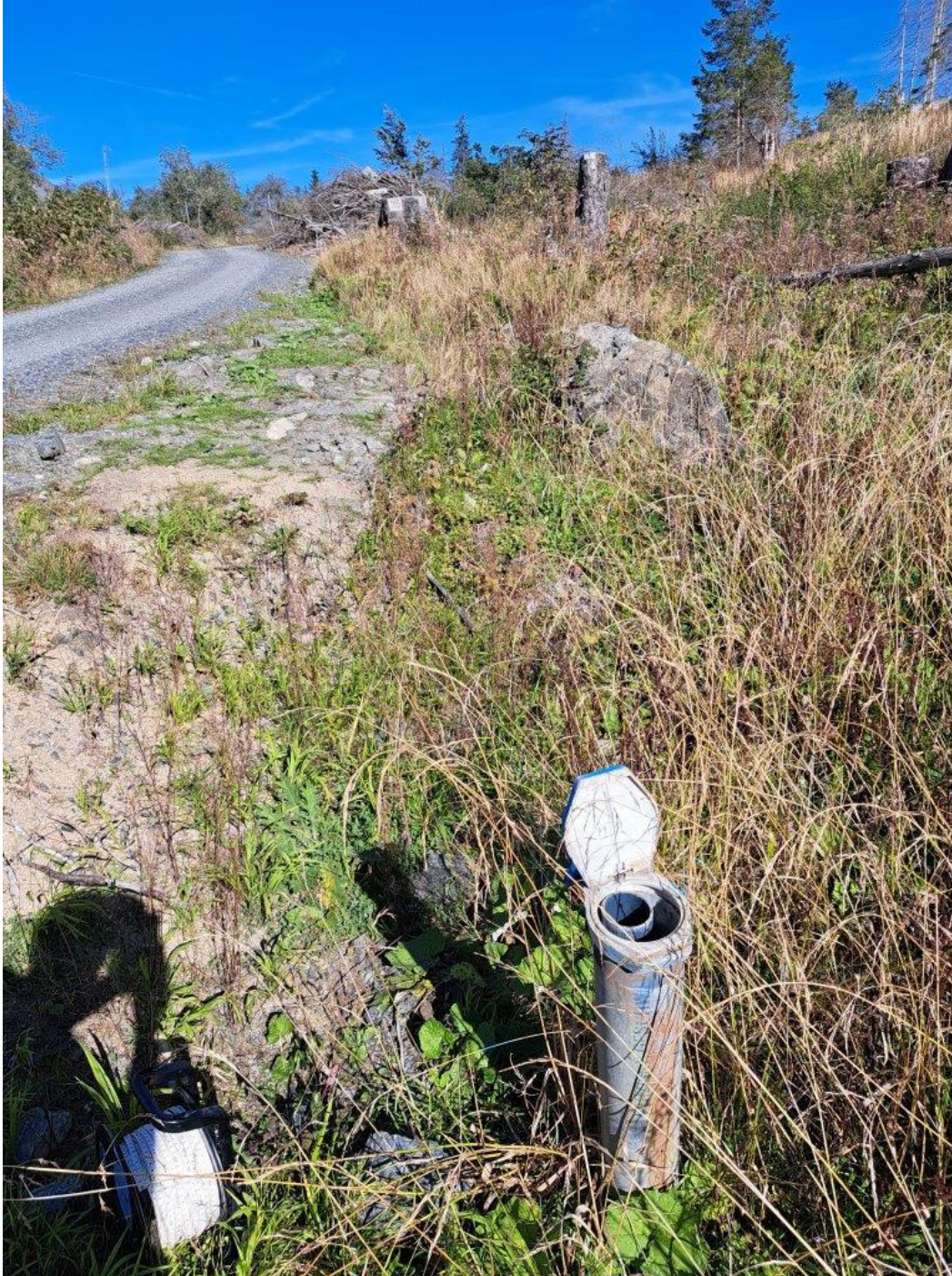
Bild 5: GWM oberhalb Stollenauslauf; September 2023
