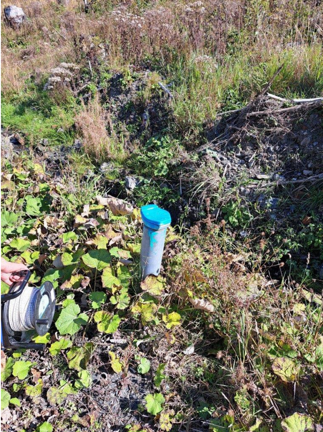
Bild 4: GWM unterhalb Stollenauslauf; September 2023
