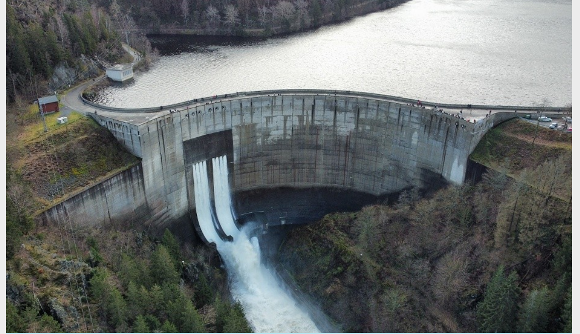
Weihnachten 2023 – Betrieb Hochwasserentlastungsanlage
