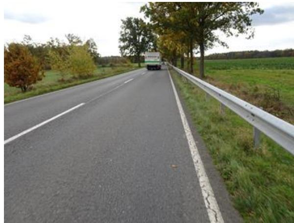
Abb. E 1-2: Fehlende Radverkehrsanlage zwischen Ehra-Lessien und Barwedel entlang der B 248 bei ca. 13.000 Kfz/Tag und Tempo 100 (LK Gifhorn)
