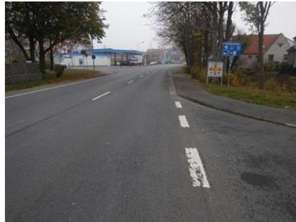
Abb. E 1-6: Fehlende Radverkehrsanlage an der L 501 in Bad Harzburg bei 8.600 Kfz/Tag und Tempo 50 (LK Goslar)
