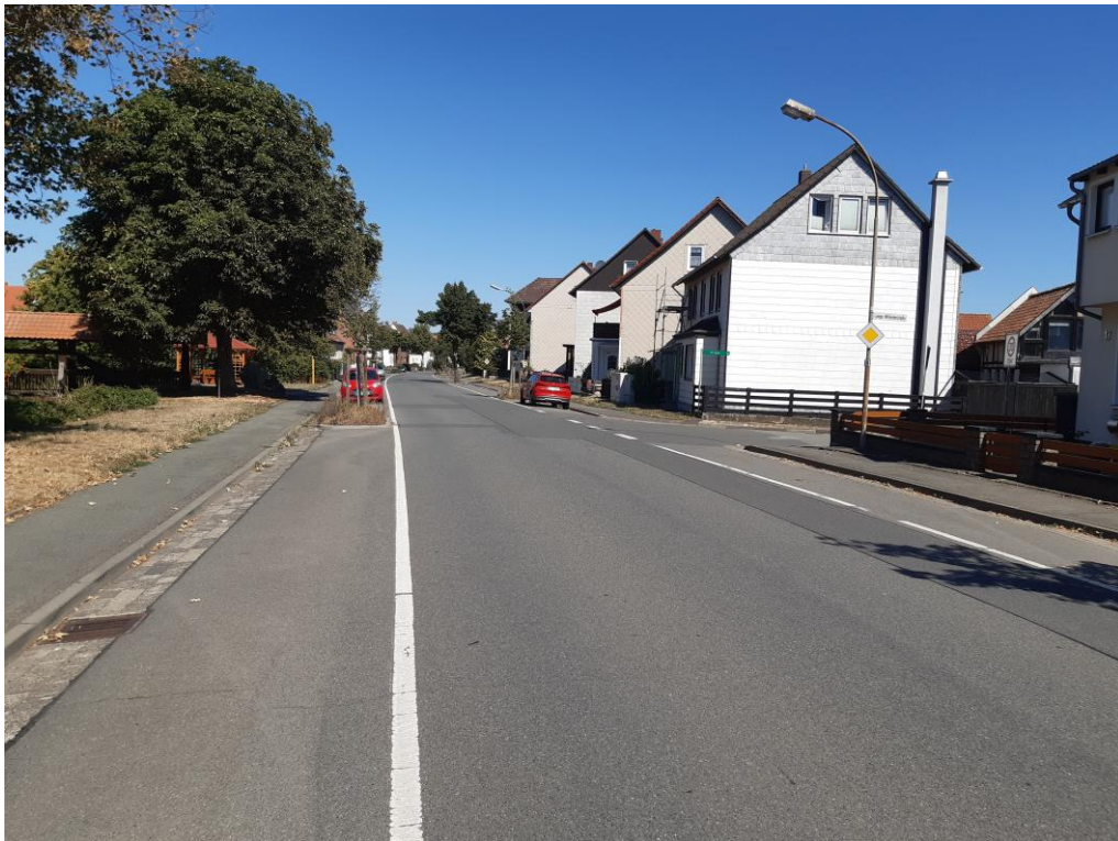
L 511, nördliche Ortsdurchfahrt Wiedelah
