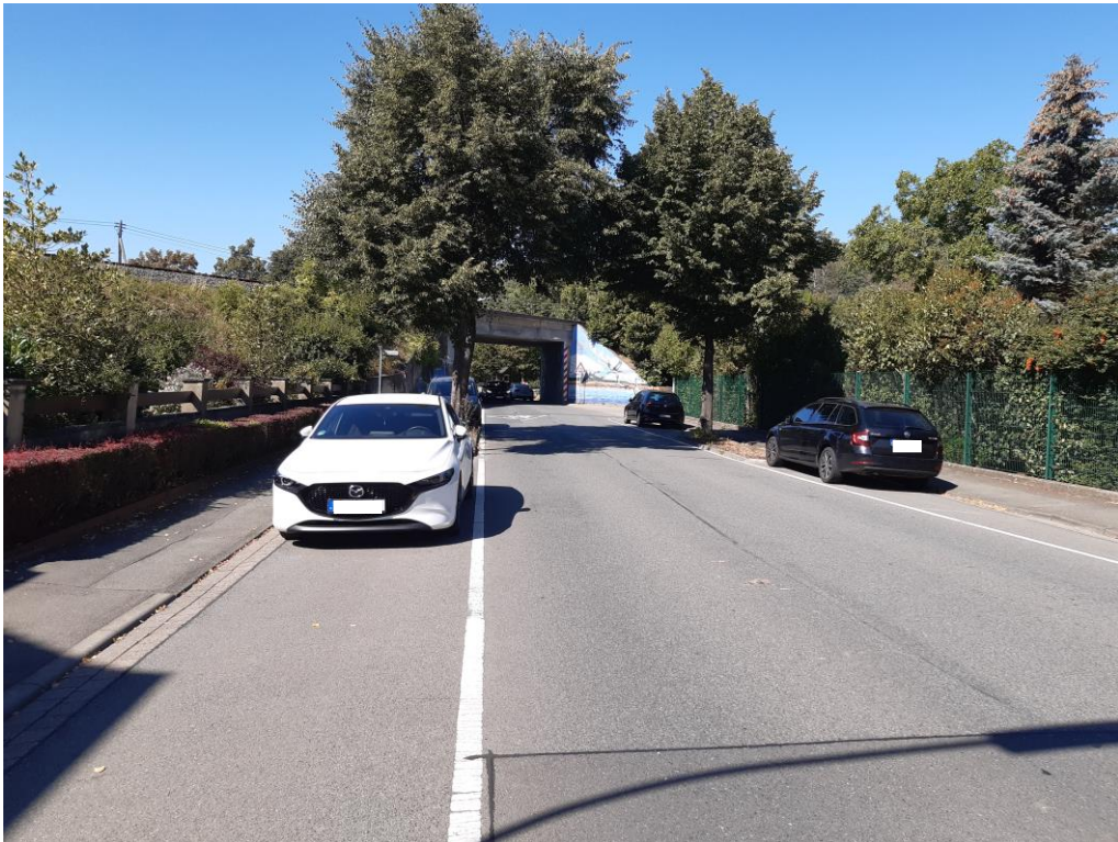
L 511, Engstelle nordöstlich Bahnbrücke
