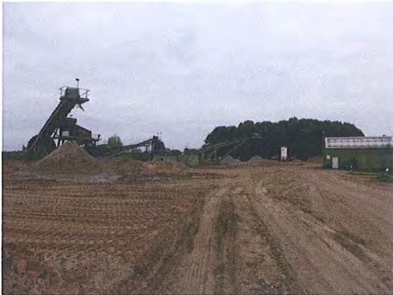
Abb. 3: Betriebsgelände mit Aufbereitungsanlage. 04.05.2014
