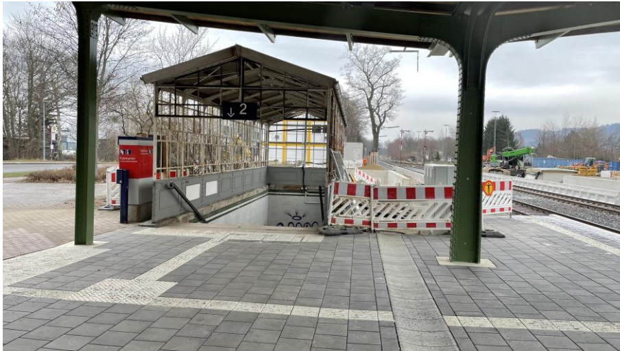
Abbildung 9: Umbau der Verkehrsstation Langelsheim; Quelle: Regionalverband Großraum Braunschweig
